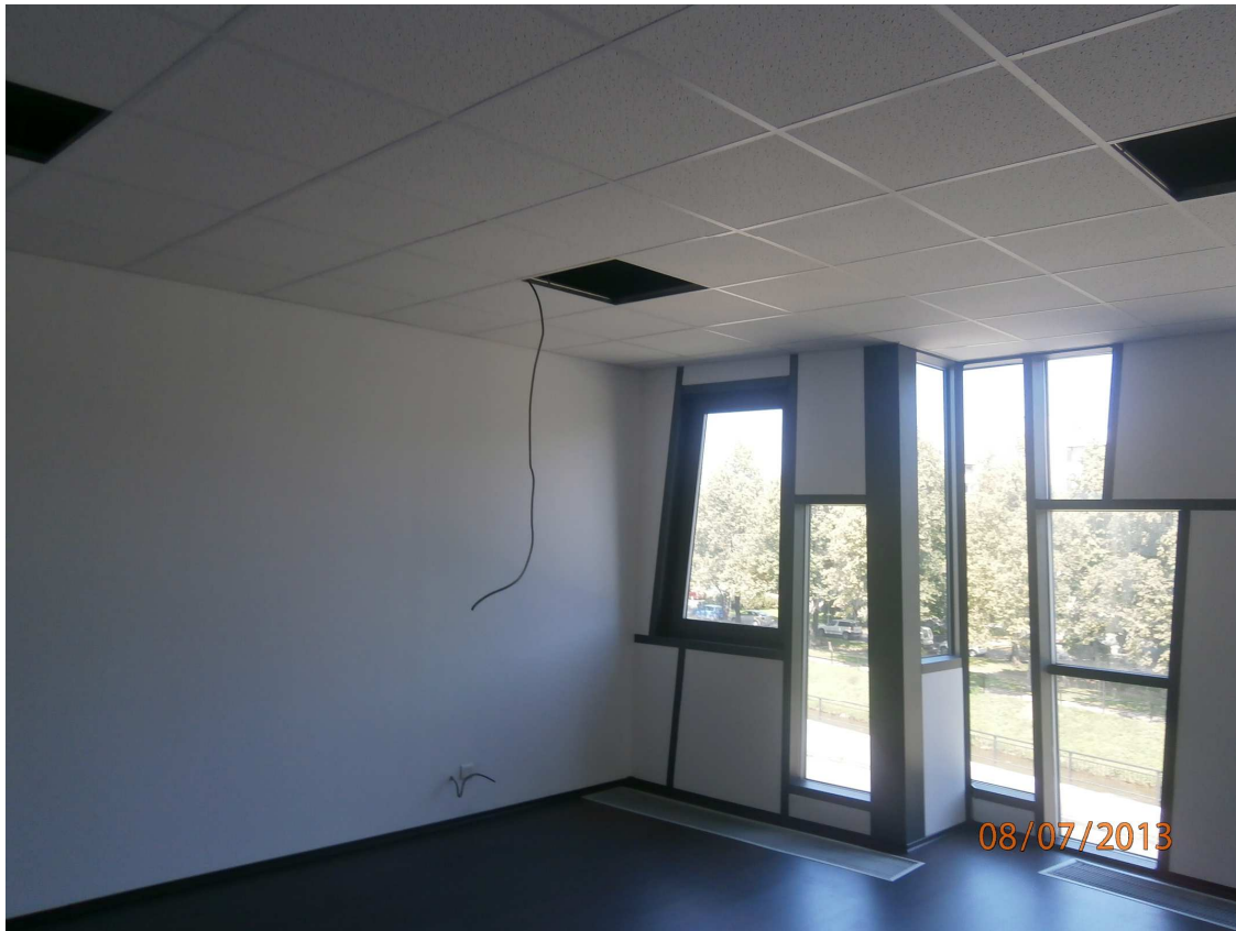
Obrázok č.3: Nebytový priestor spoločnosti BENEHOLDING, s.r.o. - interiér (montáž kabeláže)
